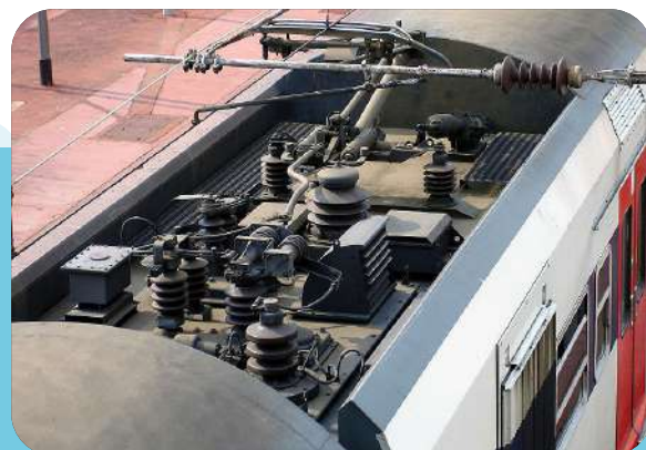
Lubrification dynamique, sous HT, de pantographes.
